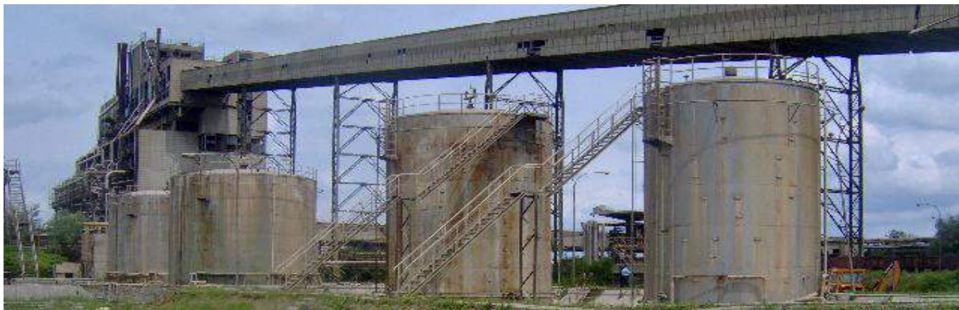
Foto 6. Pamje të disa nga rezervarët me përmbajtje të nus produkteve, të mbetura nga procesi i gazifikimit - Burimi: KEK / INKOS
